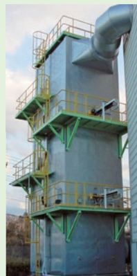
触媒式ダイオキシン類 分解除去装置
